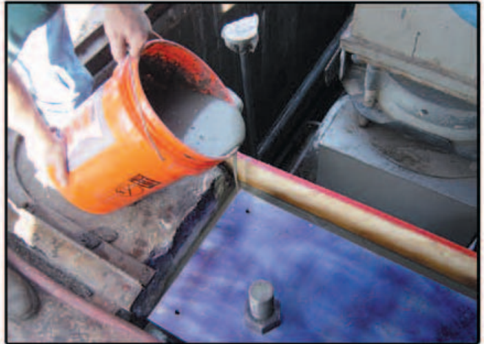
Pouring Deep Pour V-100 Grout under a sole plate.
